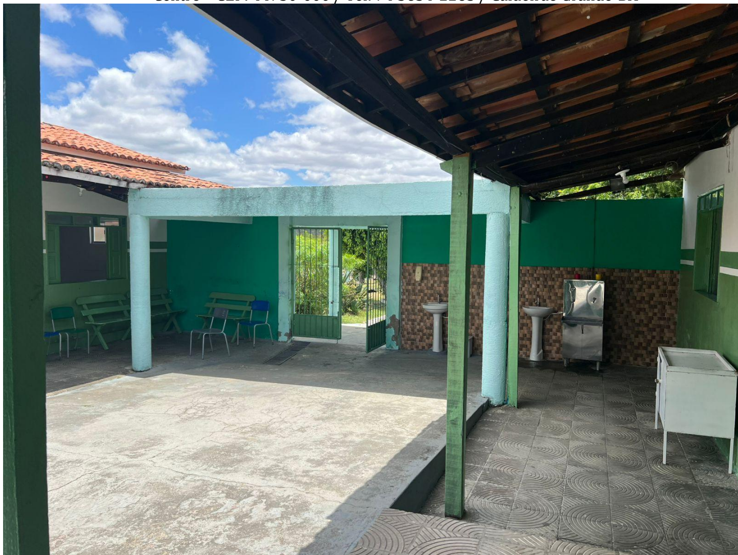
PORTÃO INTERIOR + PIAS E BEBEDOURO
